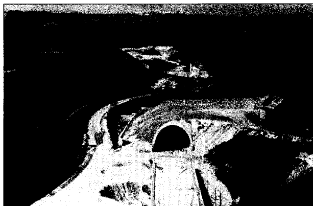
Un cantiere sulla Salerno Reggio Calabria
